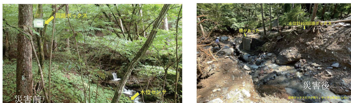
図4 9月5日の土石流発生地点に設置されていたLPWA水位計（左：災害前、右：災害後）
