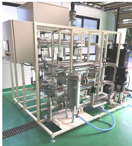
水道圧・落差圧による無電力の浄水装置
