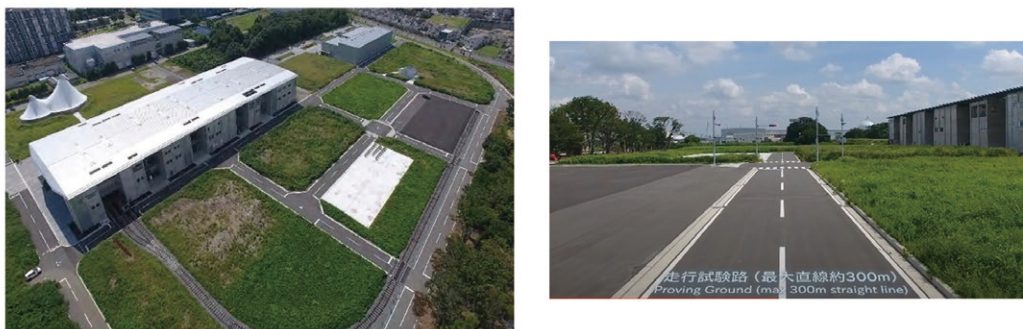
図1 東京大学生産技術研究所附属 千葉実験場 (出典： https://www.iis.u-tokyo.ac.jp/ja/about/facilities/chiba/ )
